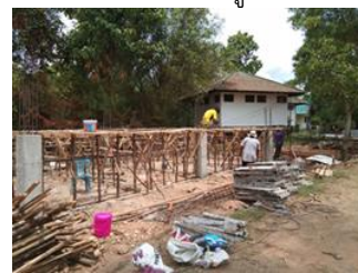
อาคารที่พักใหม่
